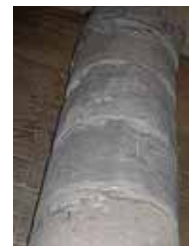
Columns in situ
